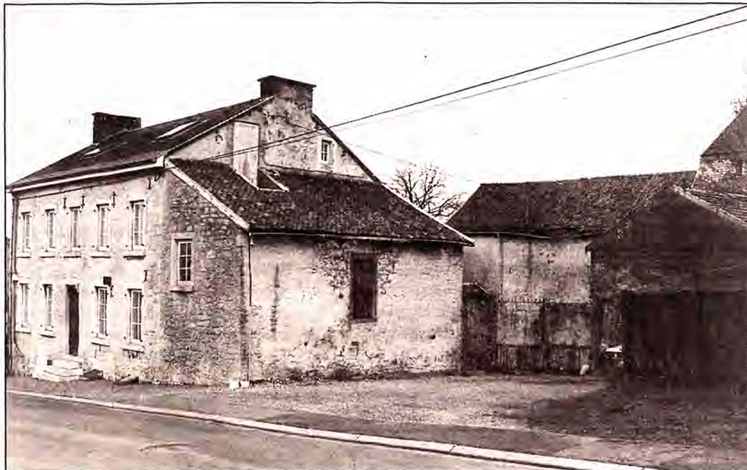
Dächer und Stallungen des Anwesens Schnellwindgasse Nr. 2 sollten nach Ansicht der Stadt Eupen nicht wie vorgesehen unter Schutz gestellt werden, um eine Nutzbarmachung des Anwesens zu Wohnzwecken nicht zu gefährden.
