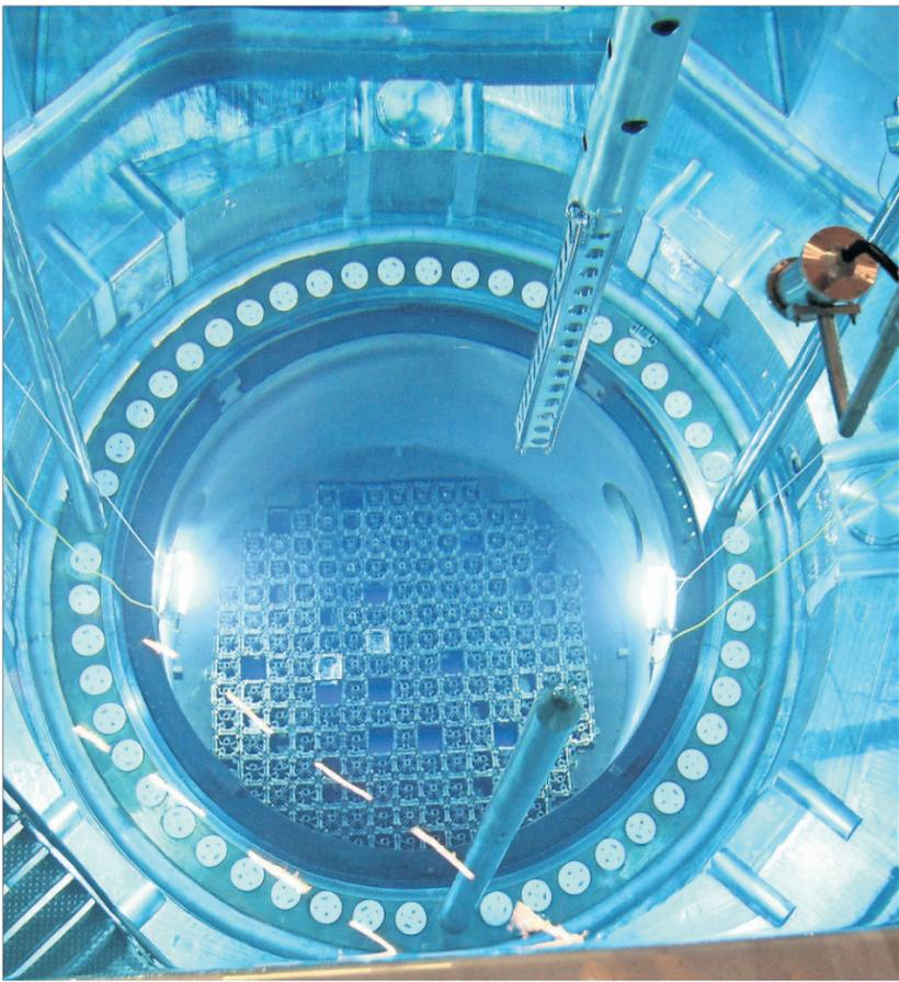
Blick in einen für den Brennelementewechsel geöffneten Reaktorblock. Foto: dpa
